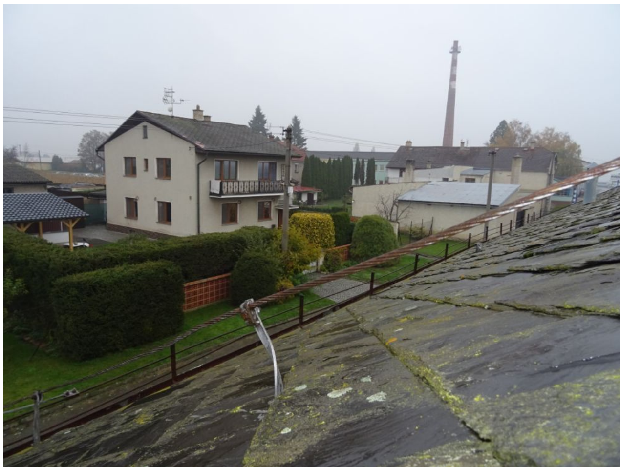
153 Pohled na střešní krytinu - kotvení hromosvodu.jpg
