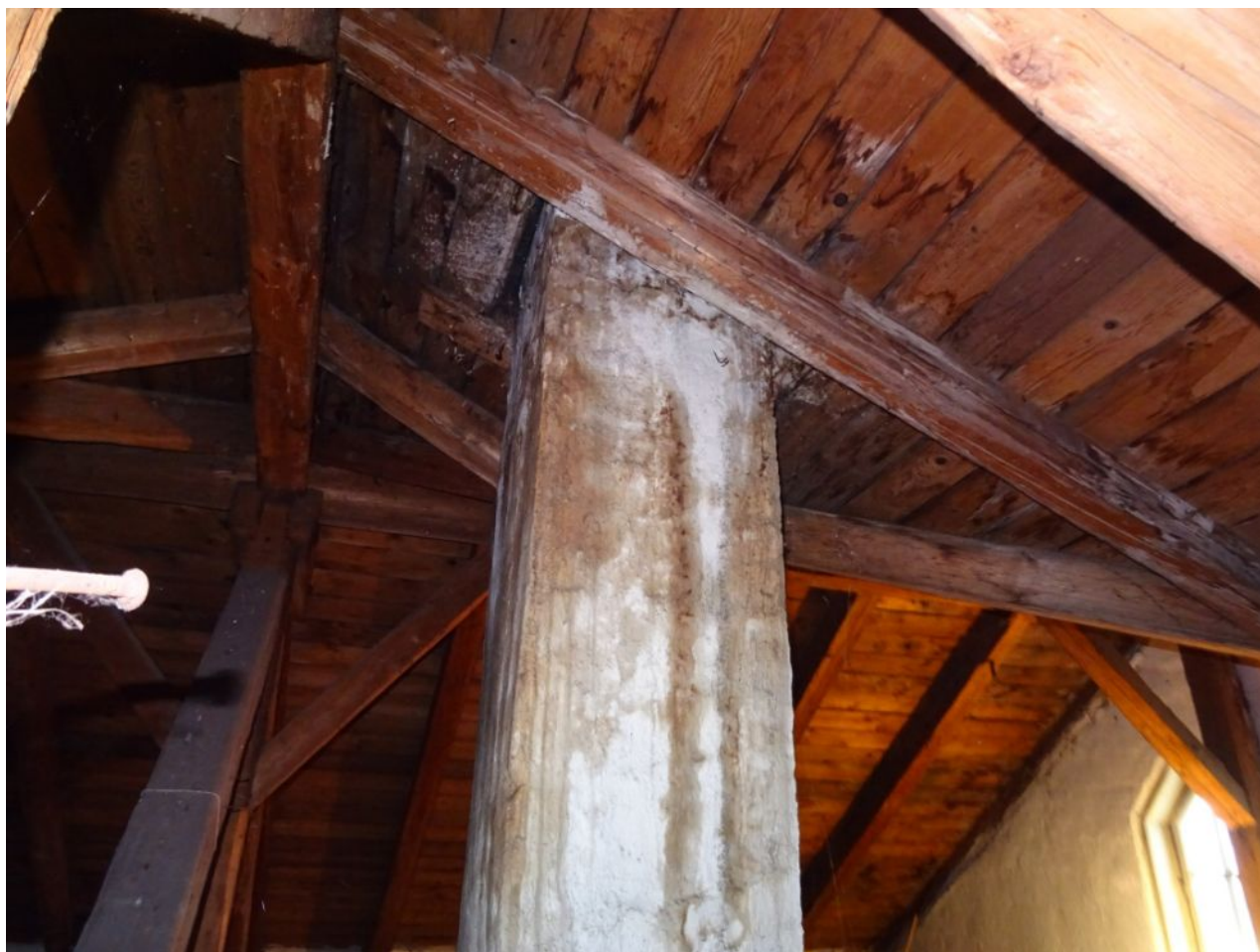
135 2NP Stopy zatékání.jpg
