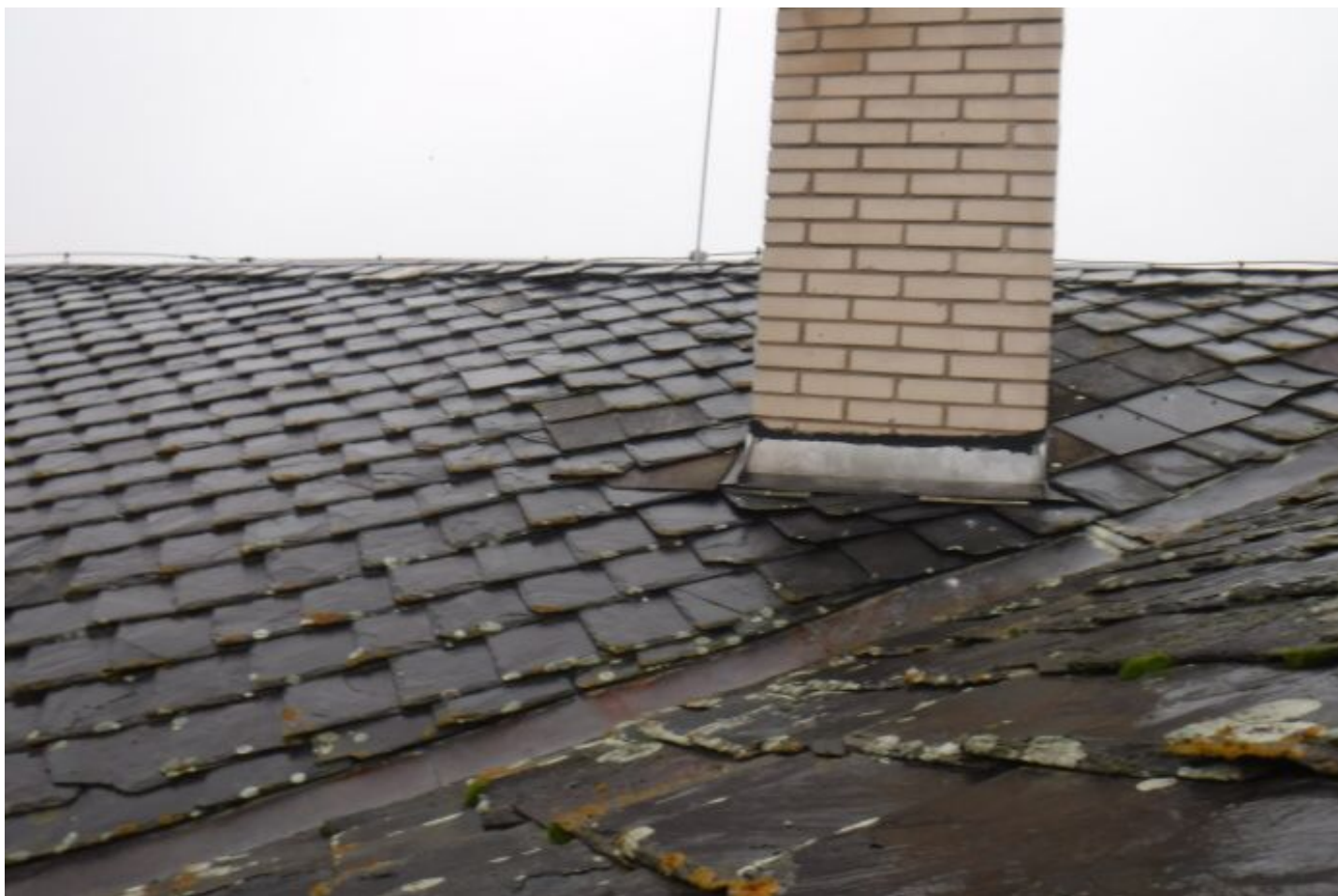
159 Pohled na střešní krytinu - těsnění komína.jpg
