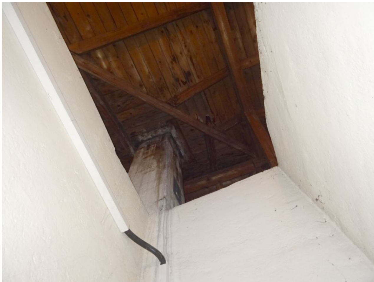
121 2NP Prostup komína střechou nad schodištěm - stopy zatékání.jpg
