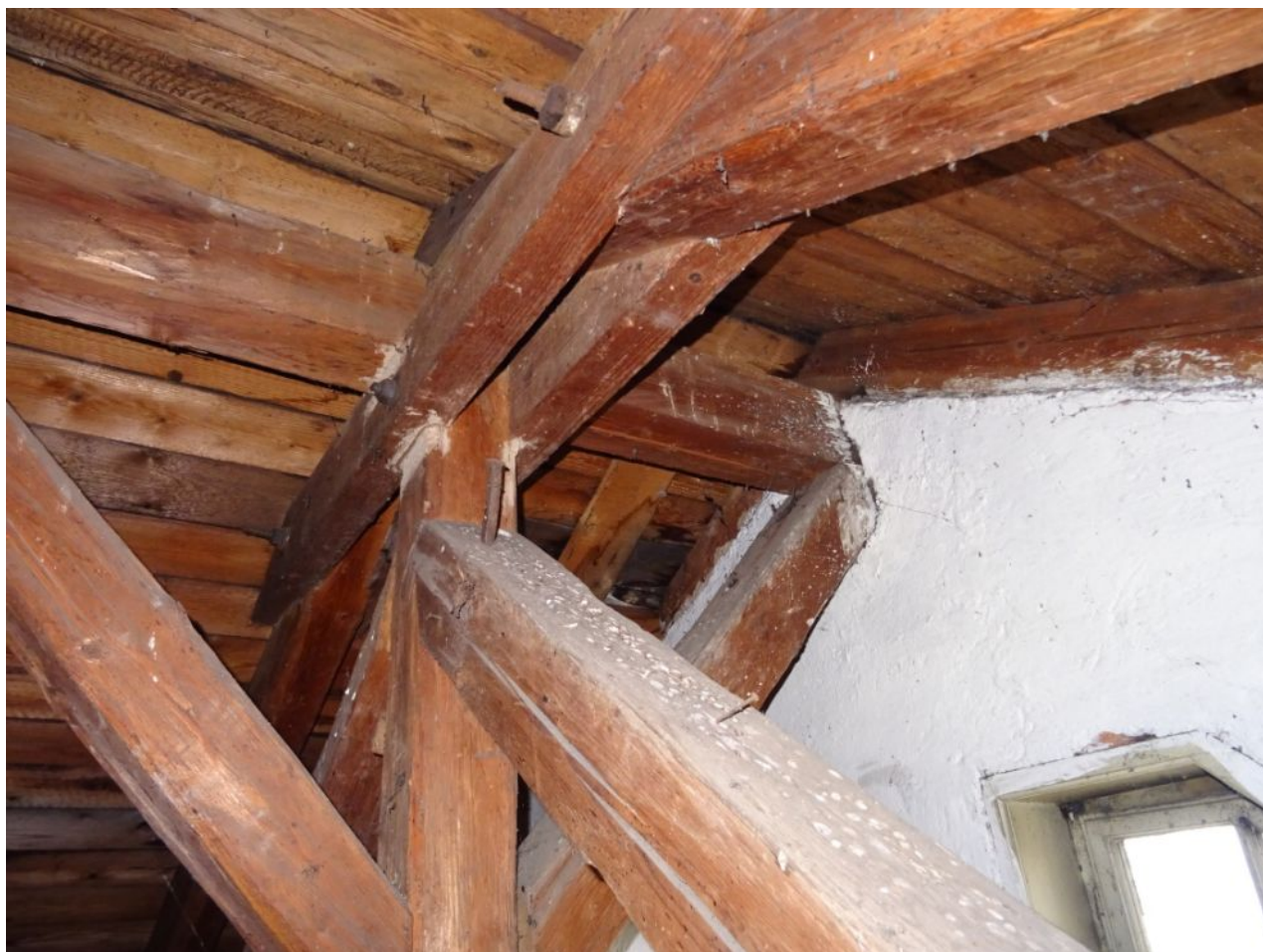
139 2NP Stopy zatékání u štitové stěny.jpg
