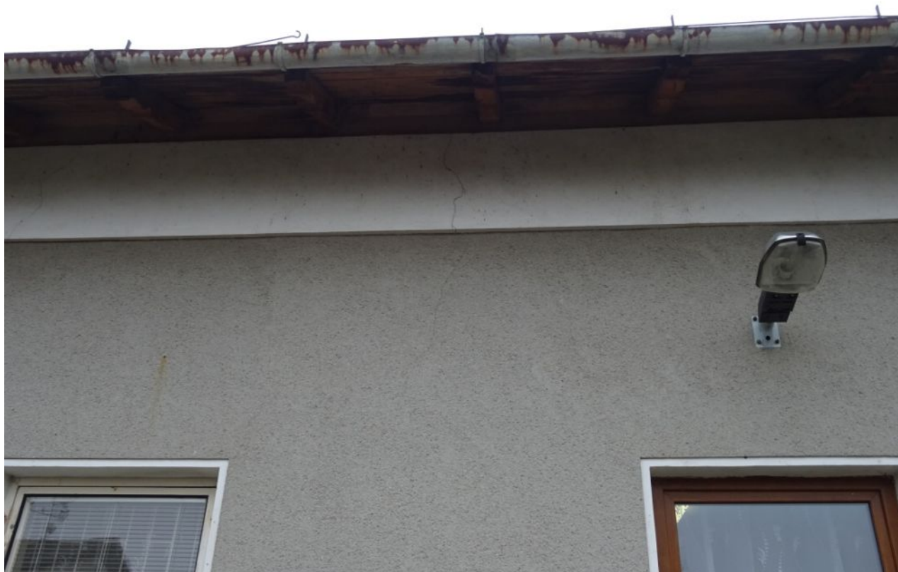
043 Pohled na prokreslenou trhlinu na SZ fasádě budovy - detail.jpg
