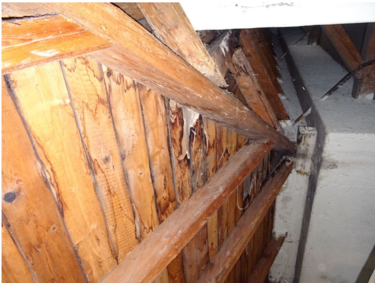
137 2NP Stopy zatékání - jihovýchodní úžlabí.jpg
