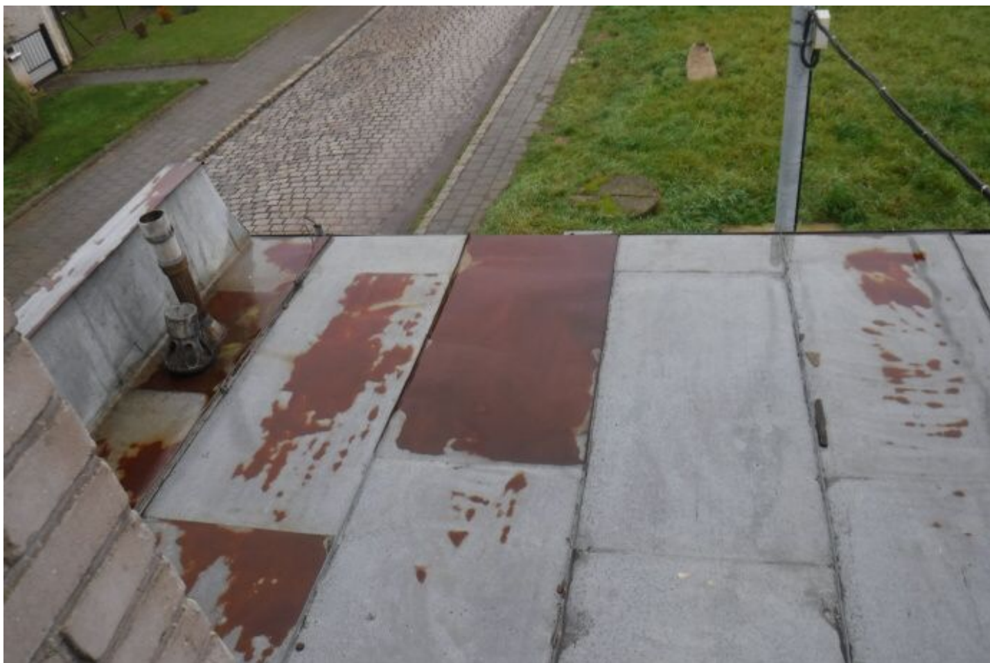
167 Pohled na střechu přístavby - odpadlá hlavice odvětrání kanalizace.jpg
