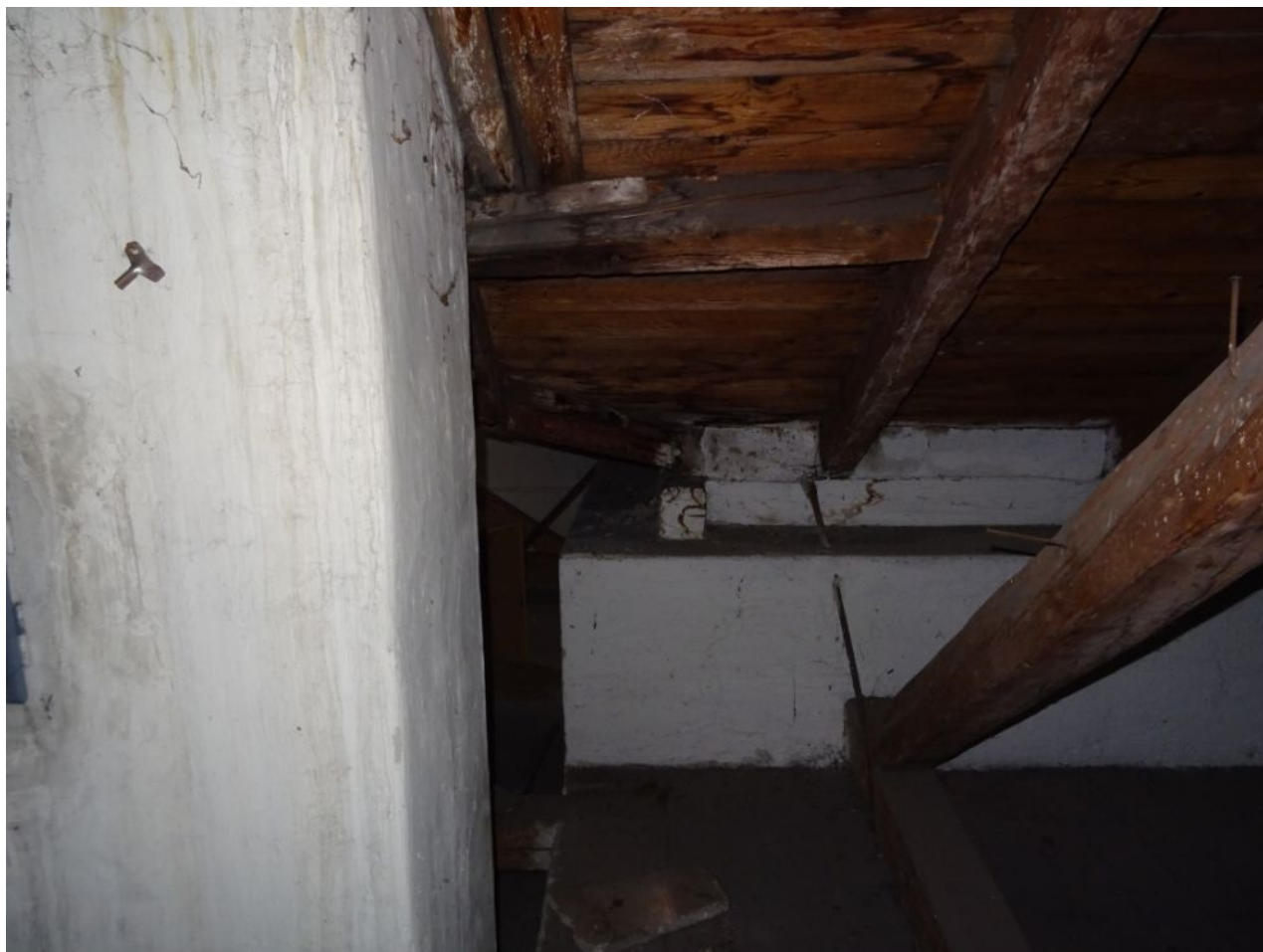
138 2NP Stopy zatékání - jihovýchodní úžlabí.jpg
