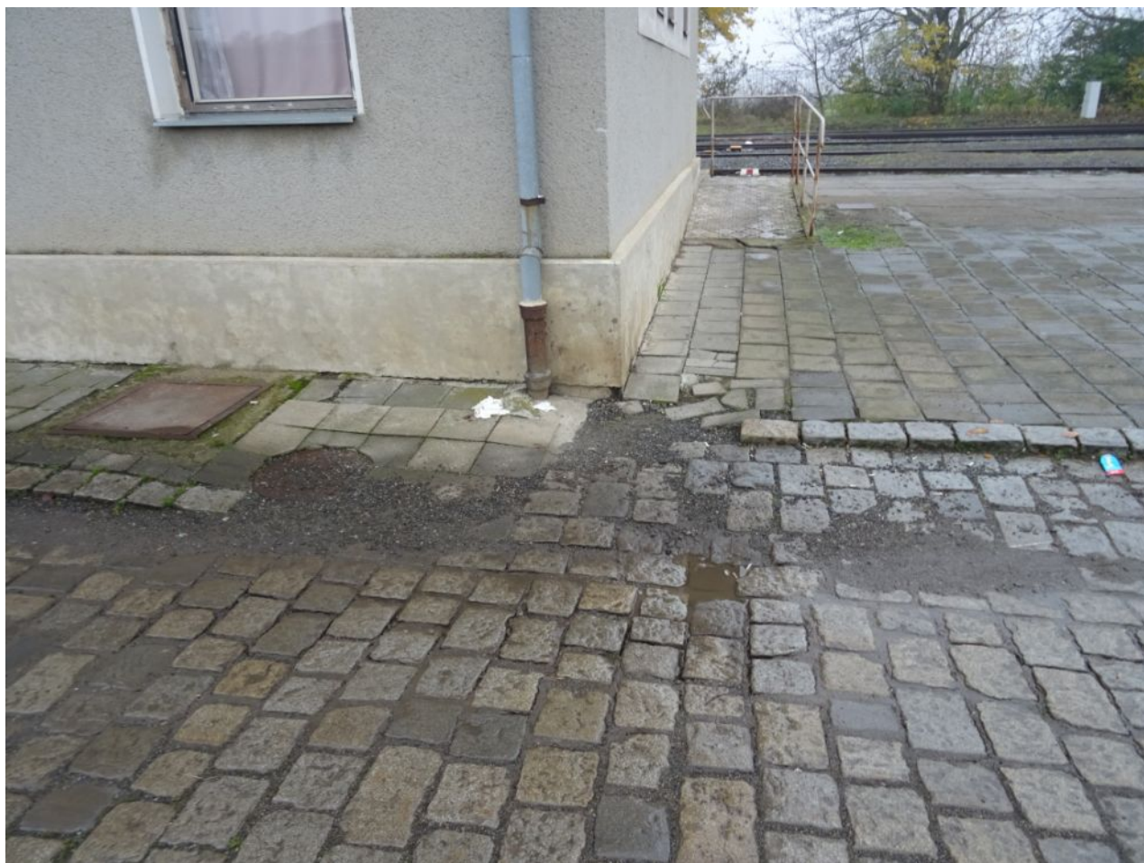
041 Pohled na SZ stěnu - propad dlažby v blízkosti odvodnění.jpg
