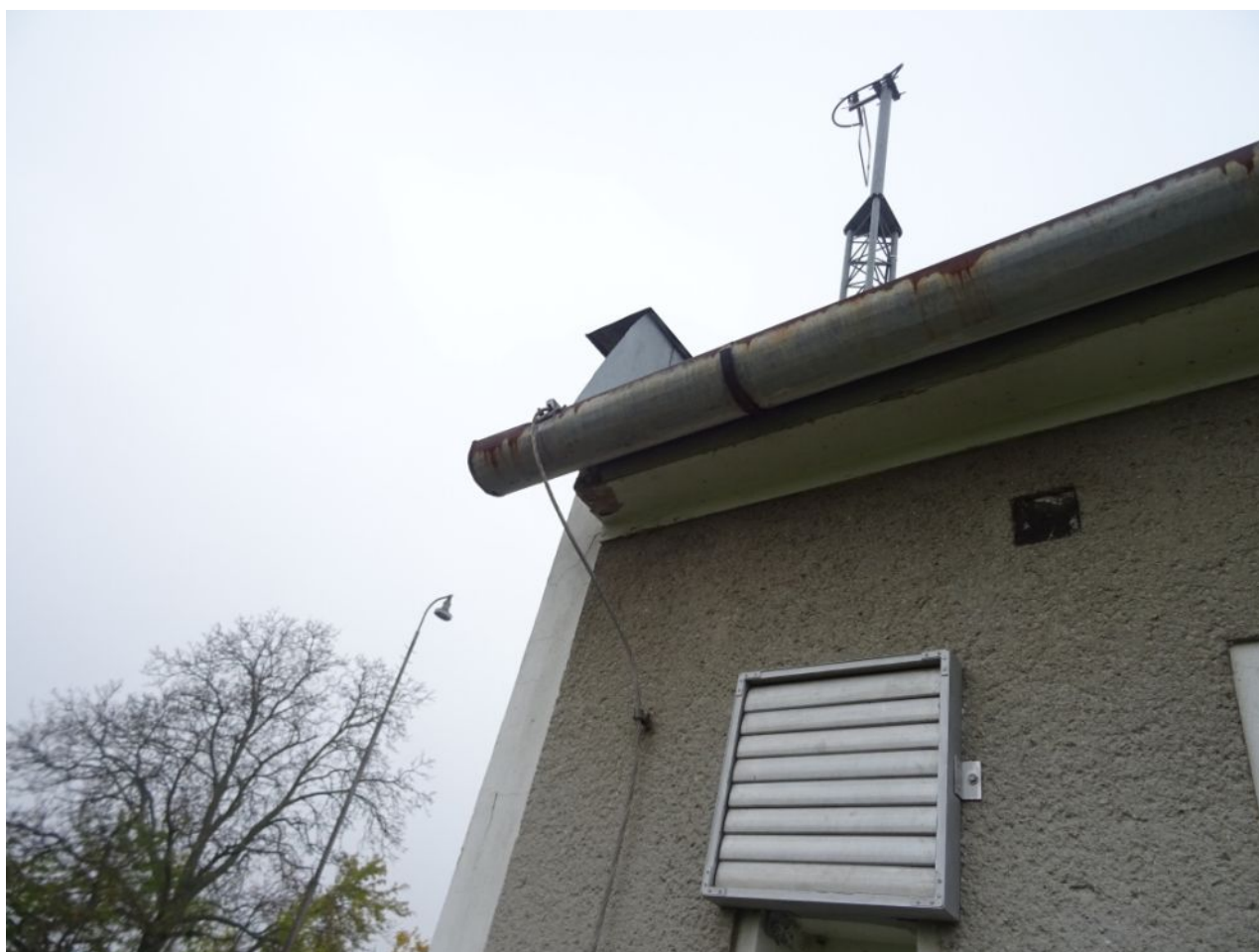
028 Koroze okapových svodů.jpg
