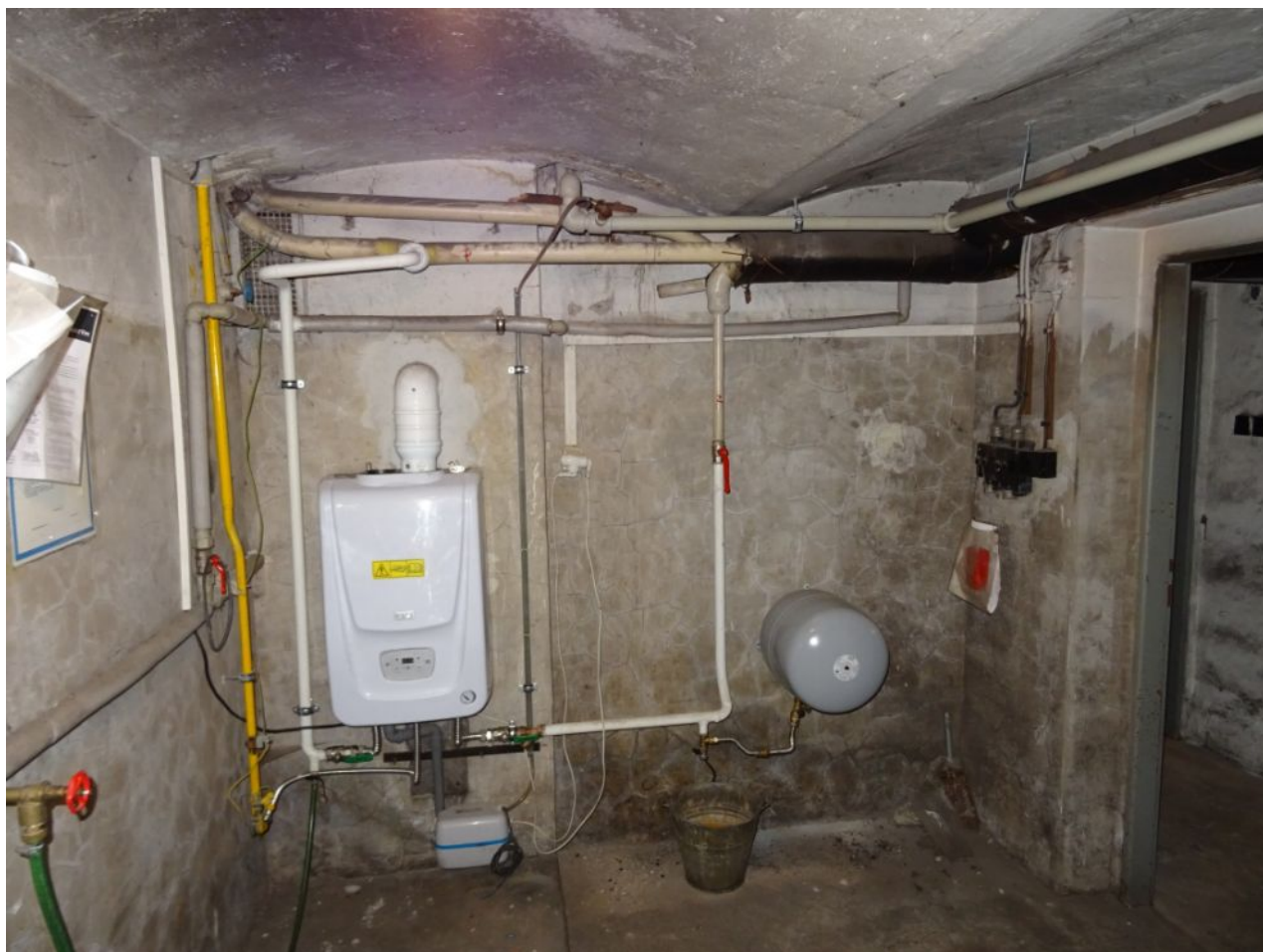
063 Poruchy kletované omítky v kotelně v suterénu.jpg
