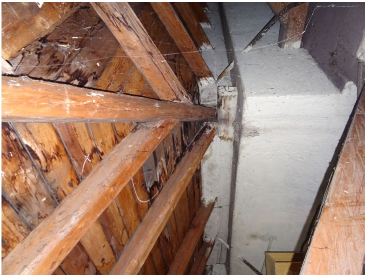
136 2NP Stopy zatékání - jihovýchodní úžlabí.jpg
