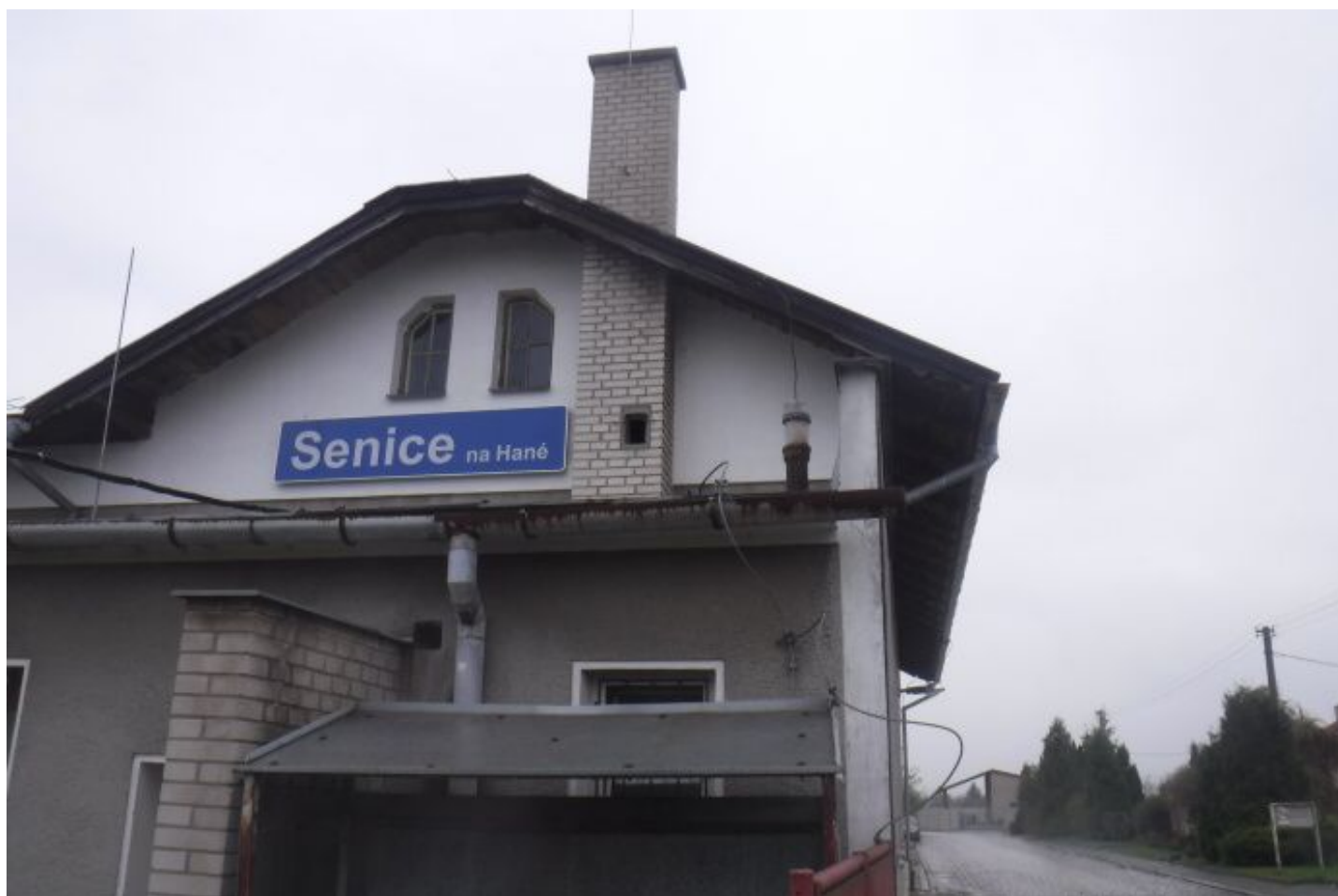
032 Přístřešek na popelnice a koroze okapových svodů.jpg
