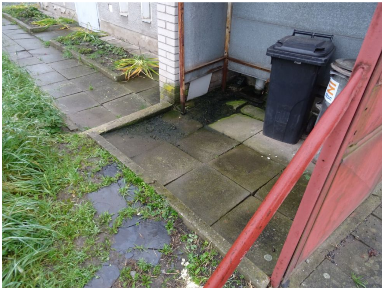
033 Propad dlažby u nefunkčního gajgru na SV straně objektu.jpg
