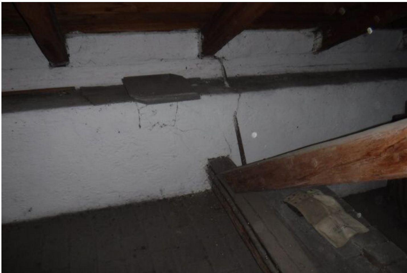
142 2NP Uložení vazného trámu do stěny a trhlina.jpg
