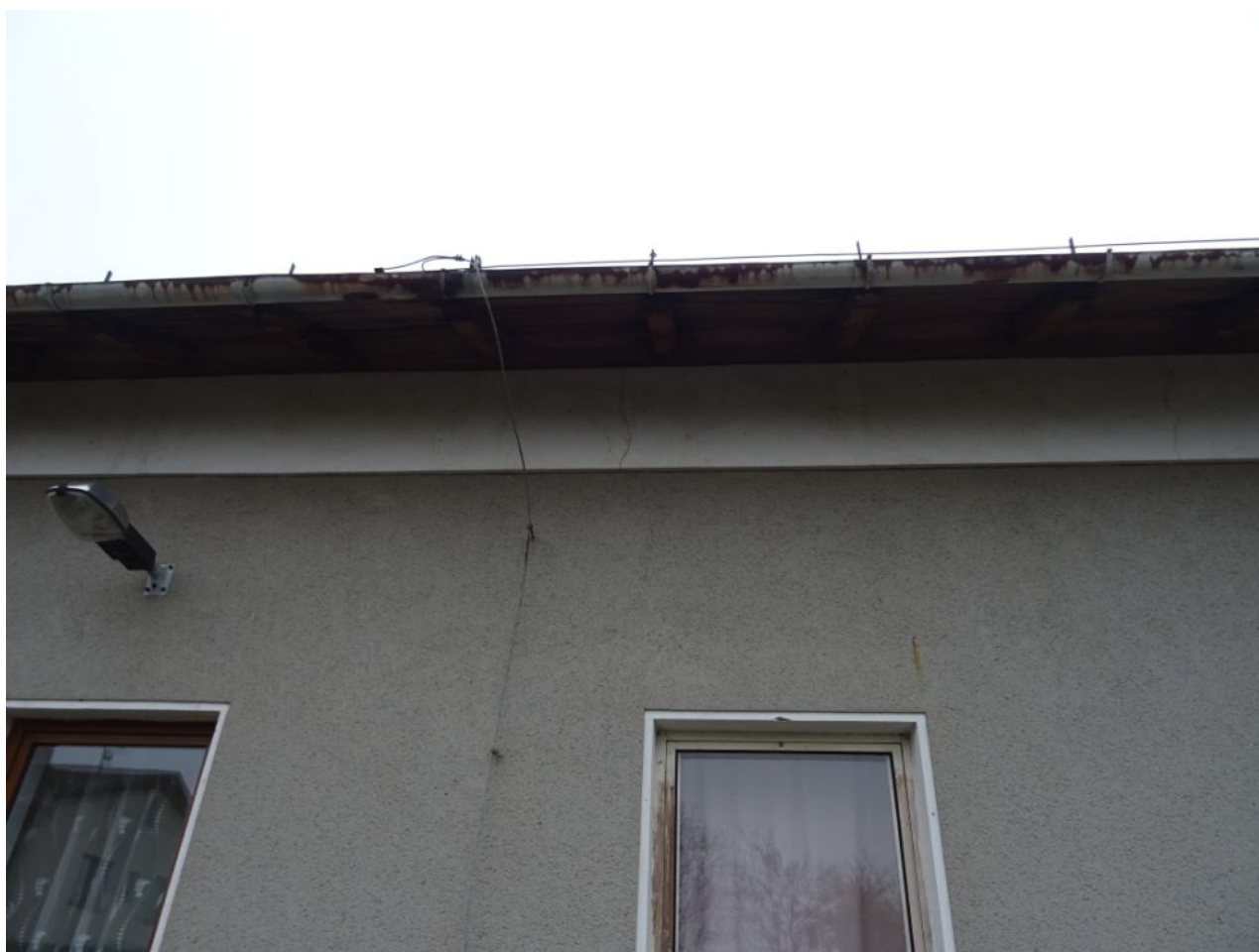
044 Pohled na prokreslenou trhlinu na SZ fasádě budovy.jpg
