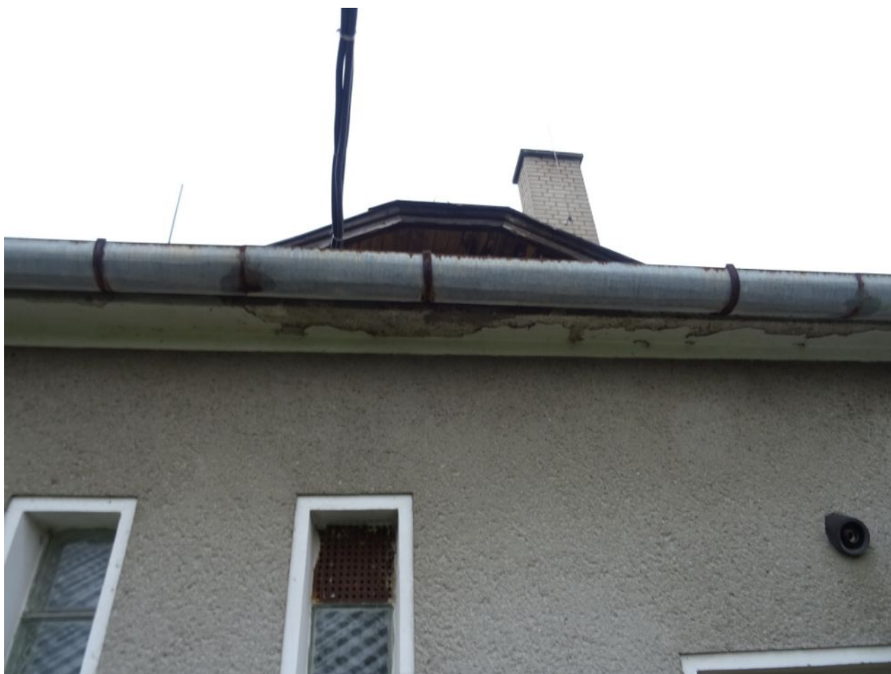
027 Zatékání na římsu .jpg
