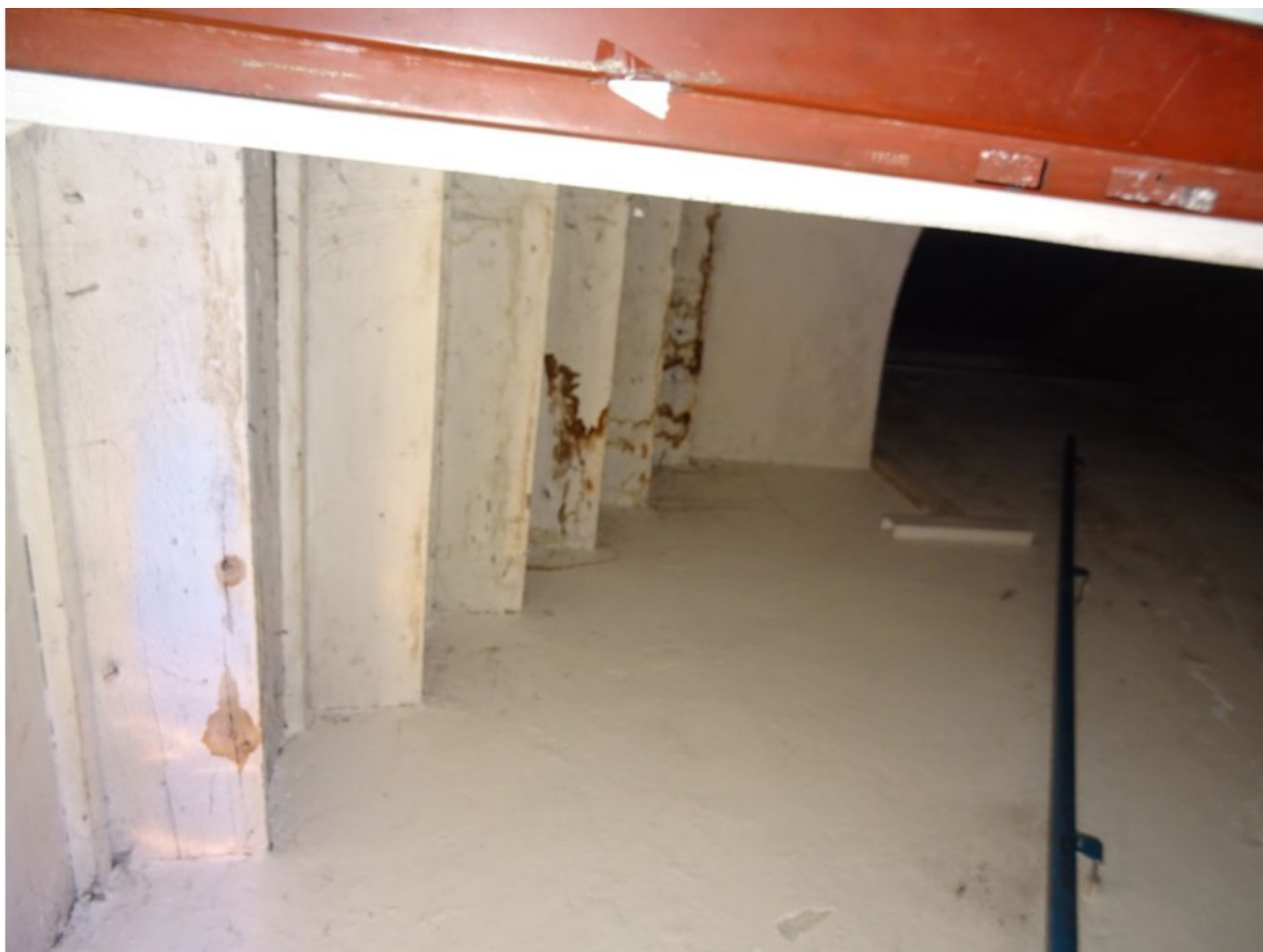
048 Zatékání na dřevěné schody - rameno na půdu.jpg
