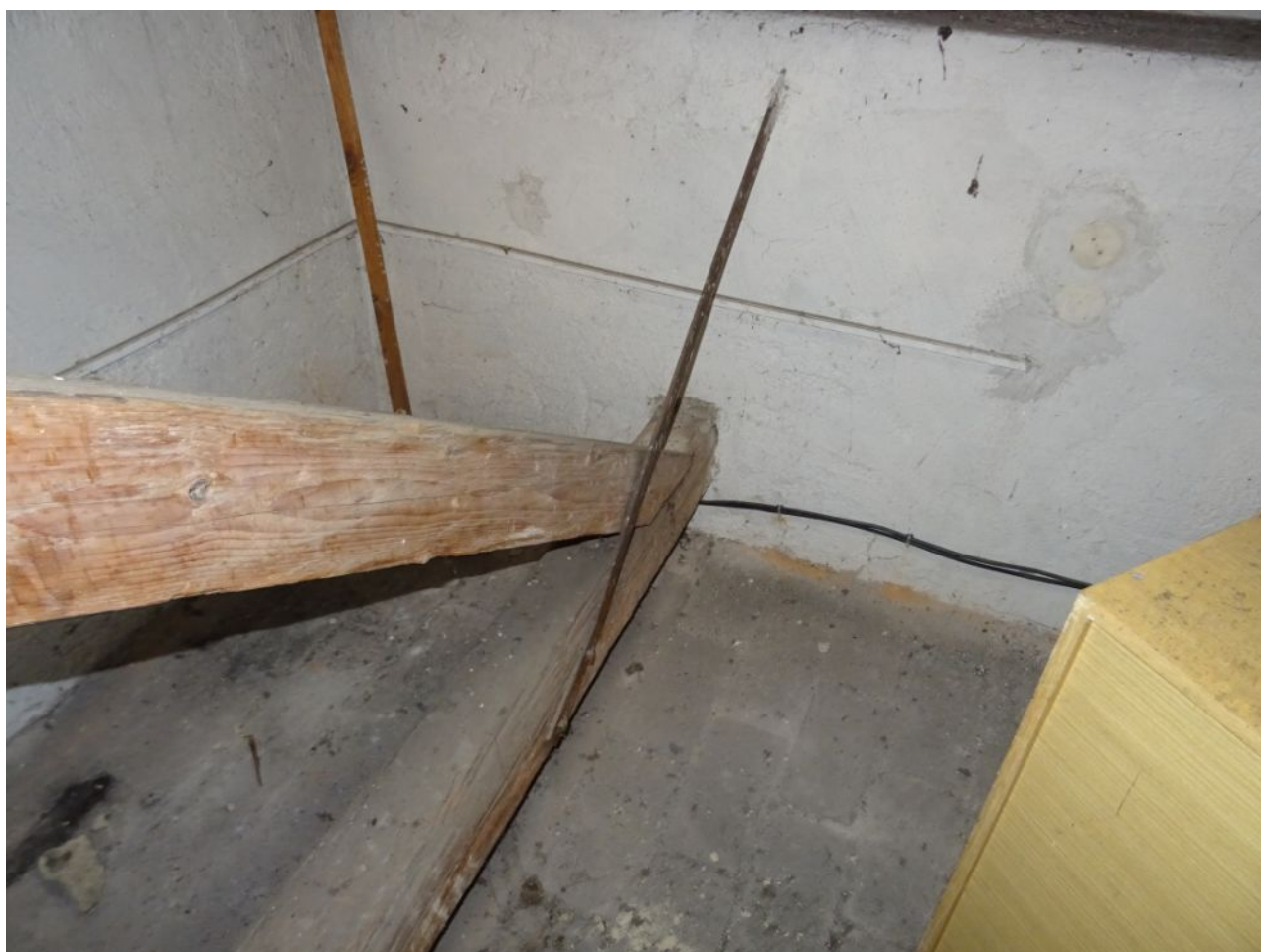
130 2NP Spojení vazného trámu s pozednicí.jpg
