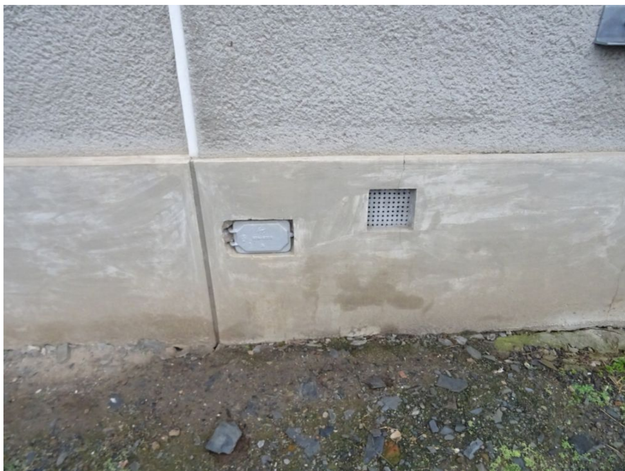
020 Pohled na dilataci mezi původním objektem a přístavbou.jpg
