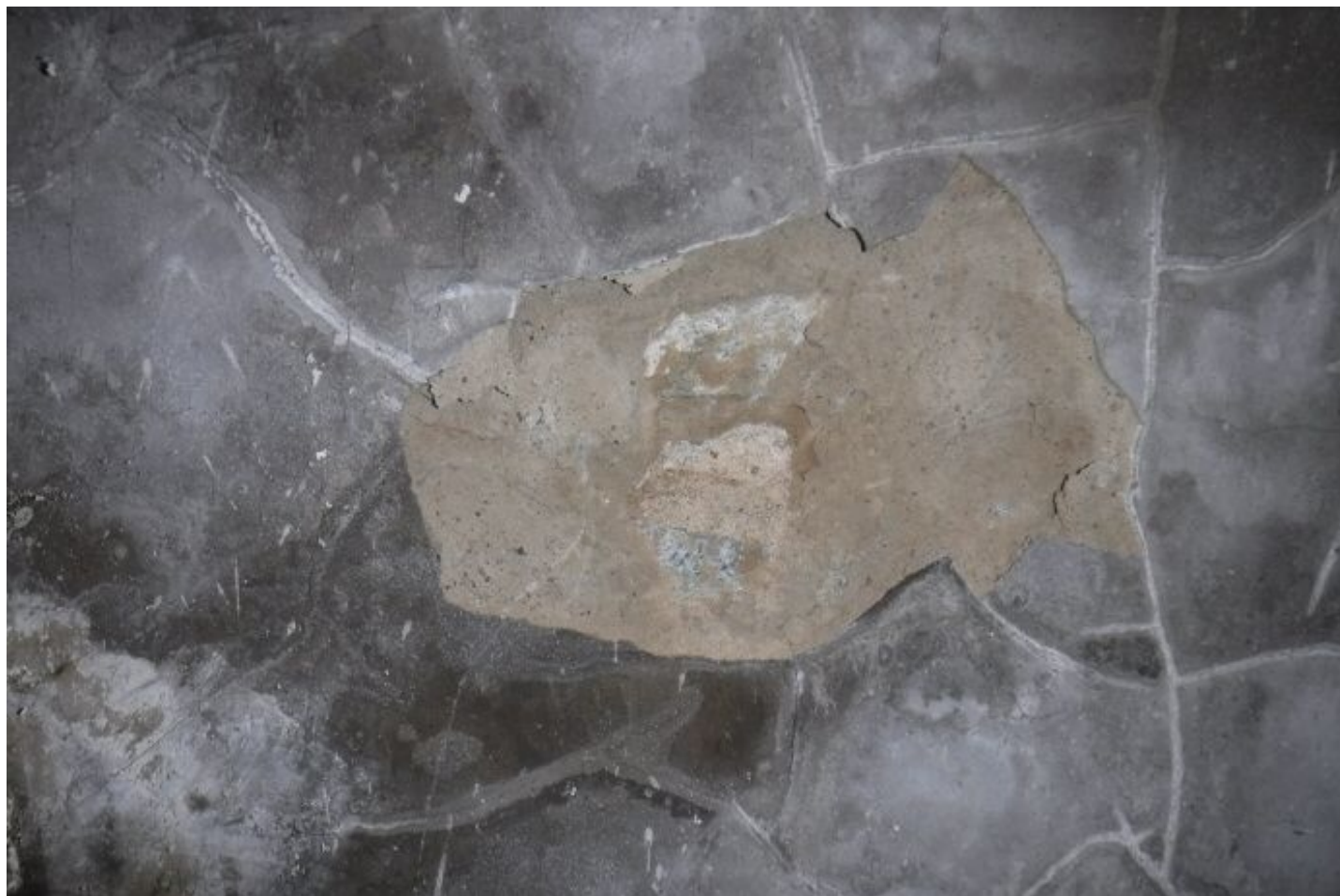
064 Poruchy kletované omítky v kotelně v suterénu - detail.jpg
