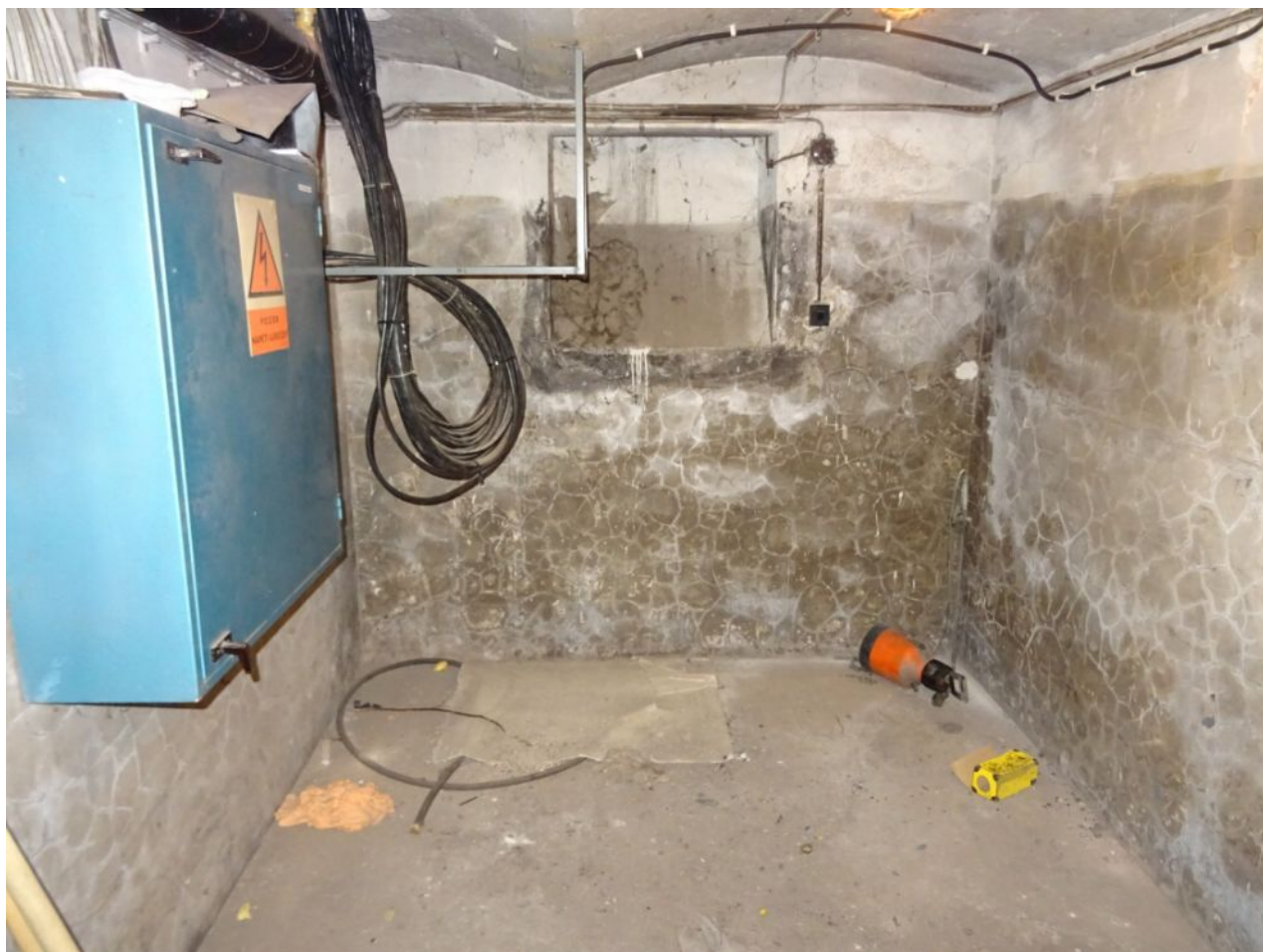
059 Poruchy kletované omítky v kotelně v suterénu.jpg
