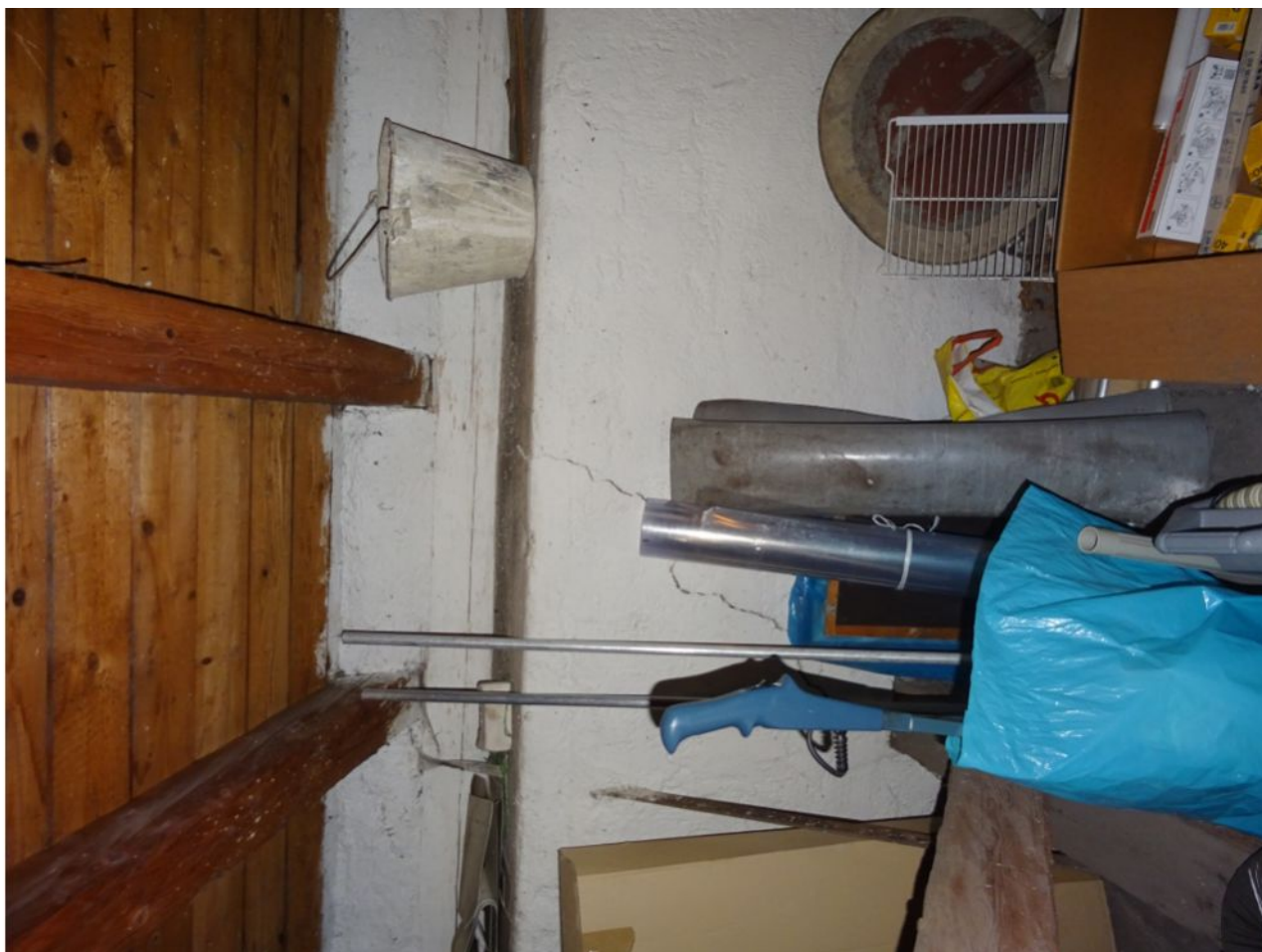
129 2NP Trhlina ve stěně v místě uložení vazného trámu.jpg
