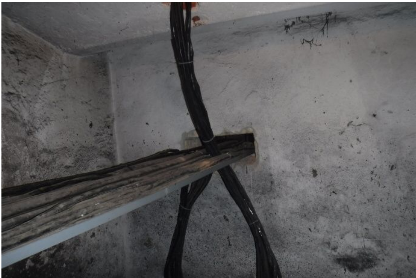
057 Prostup kabeláže stěnou.jpg
