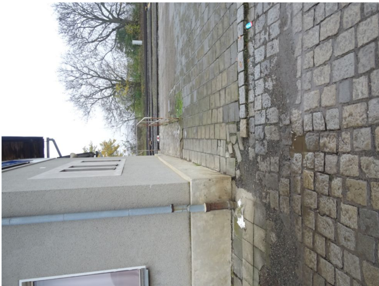
039 Pohled na SZ stěnu - propad dlažby v blízkosti odvodnění.jpg
