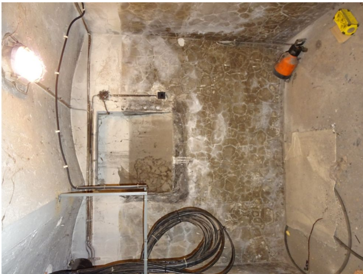
060 Poruchy kletované omítky v kotelně v suterénu.jpg
