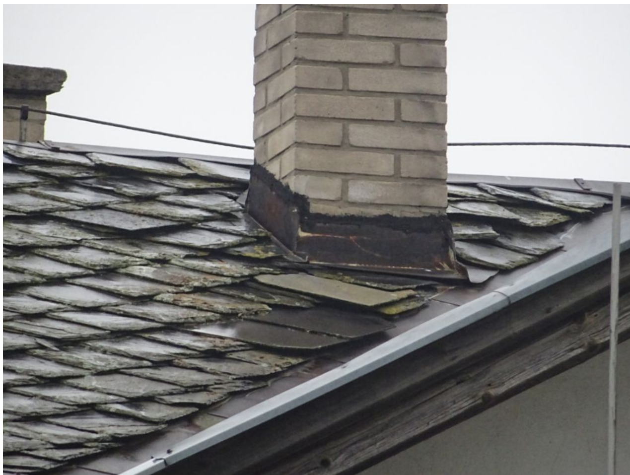
163 Pohled na střešní krytinu - těsnění okolo komína - detaily.jpg
