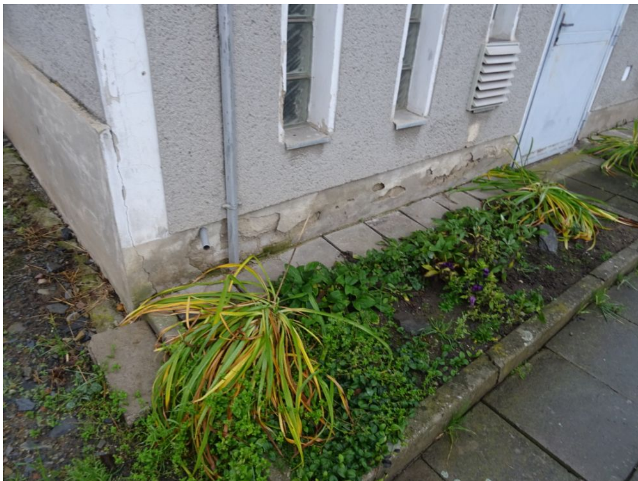
025 Pohled na SV stranu budovy a plochy před budovou - poškození soklu.jpg
