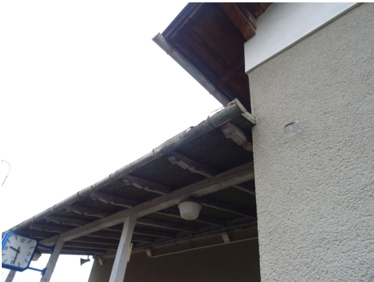
013 Zastřešení nástupiště a poškozené okapové svody.jpg
