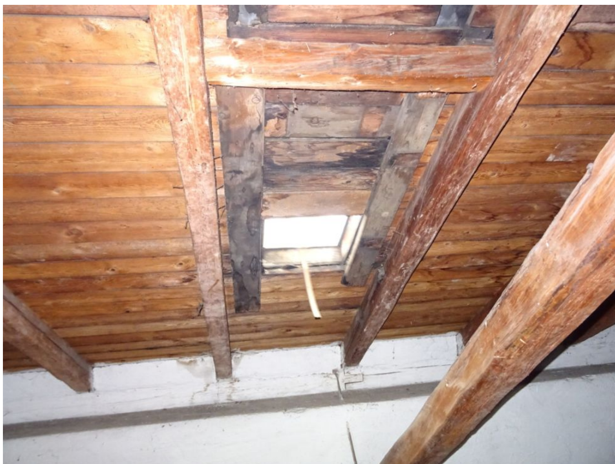
132 2NP Stopy starého zatékání okolo střešního okna.jpg
