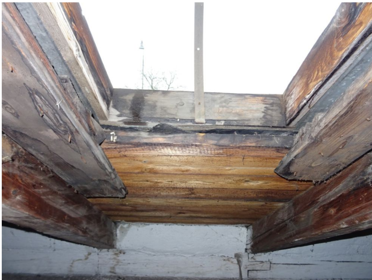
133 2NP Stopy starého zatékání okolo střešního okna.jpg
