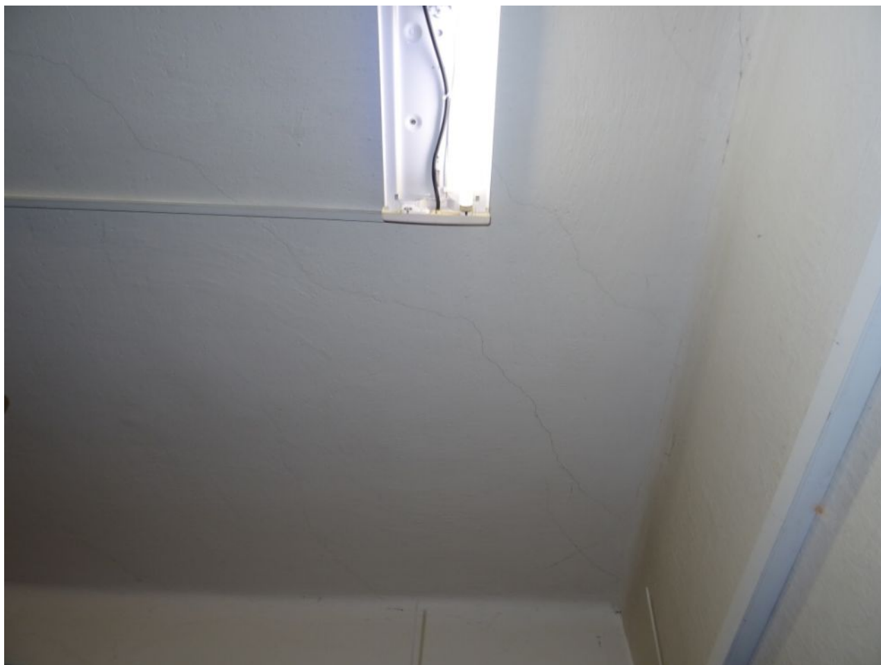
085 1NP výpravní místnost - rozvody - trhlina v omítce.jpg
