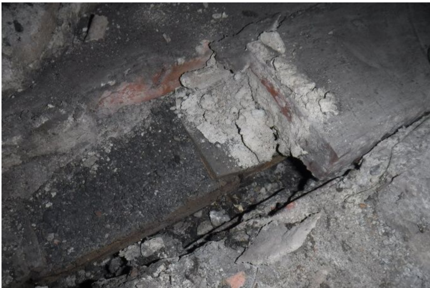
145 Sonda do konstrukce stropu nad 1.NP.jpg
