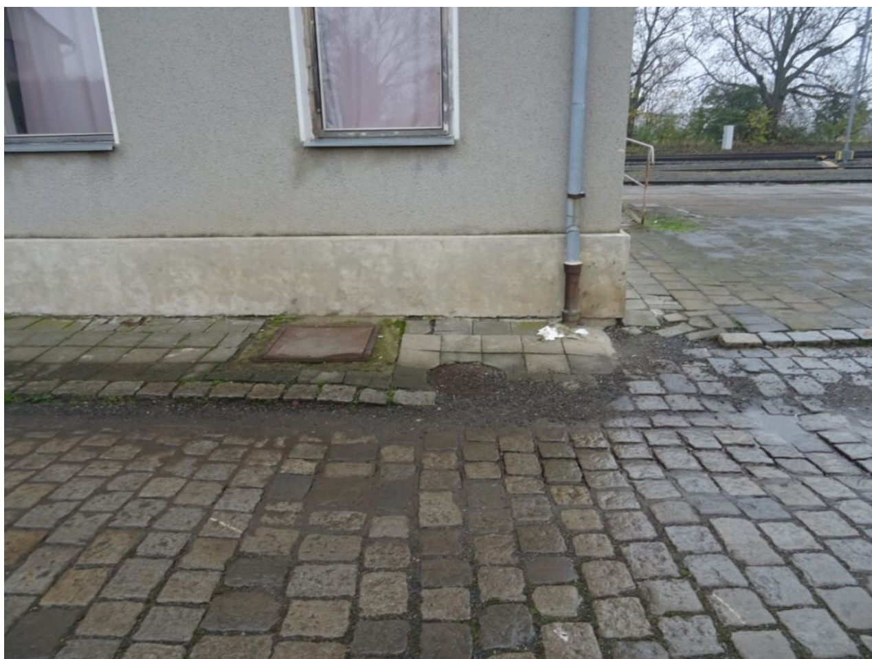
040 Pohled na SZ stěnu - propad dlažby v blízkosti odvodnění.jpg
