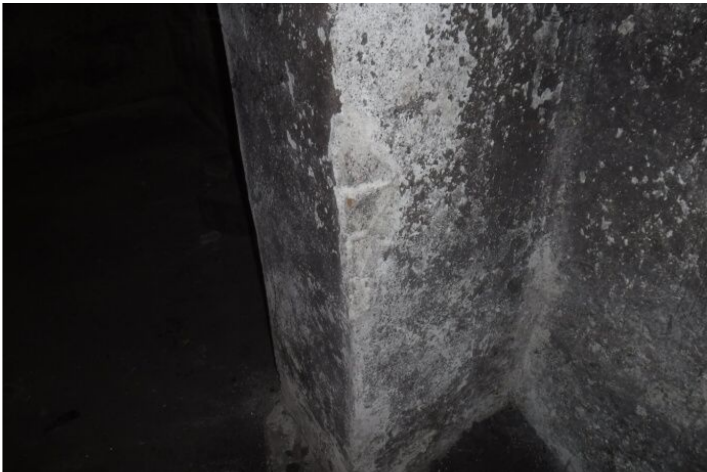
071 Zděný sloupek - odběr vzorku.jpg
