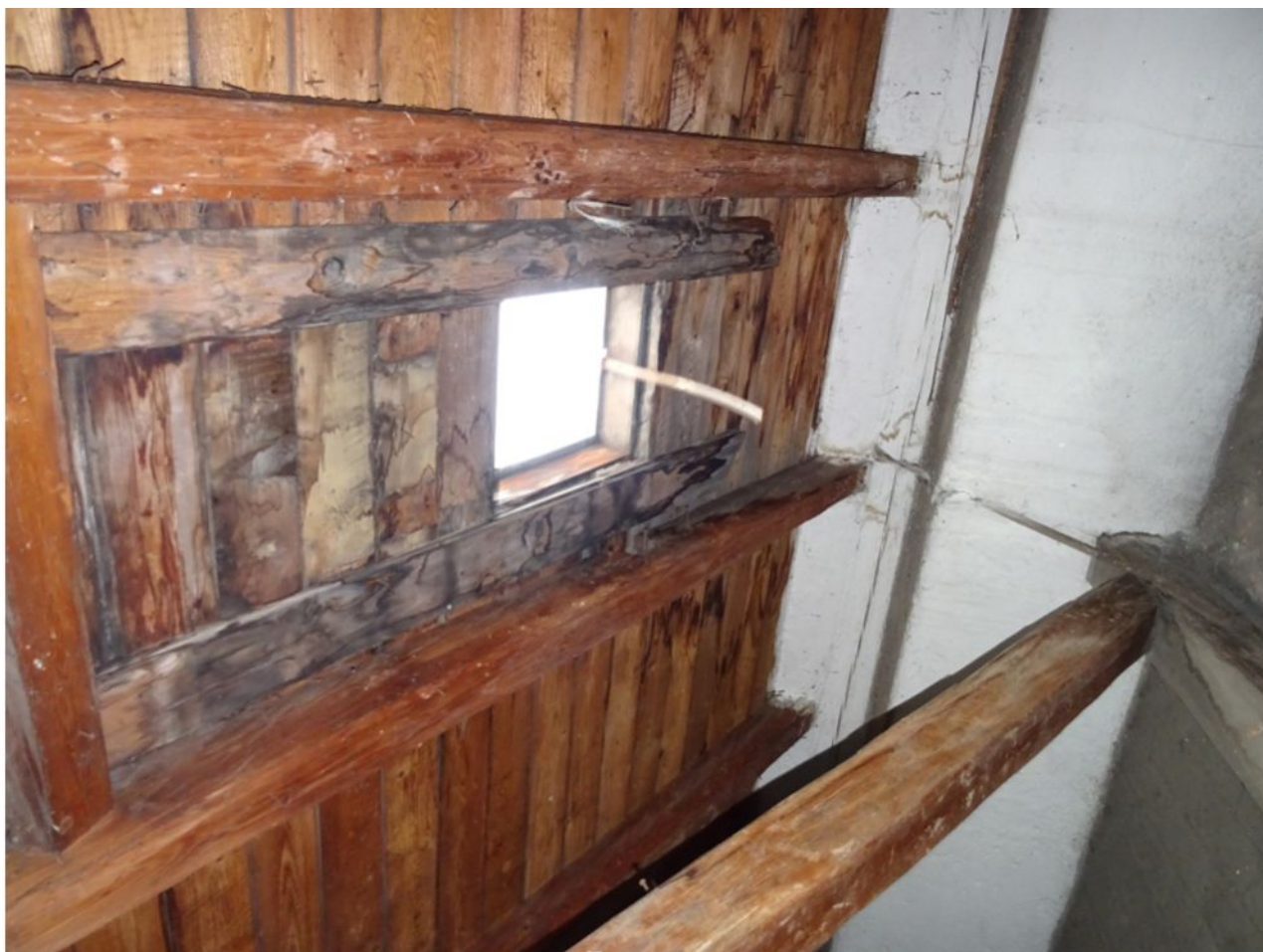
131 2NP Spojení vazného trámu s pozednicí - stopy starého zatékání okolo střešního okna.jpg
