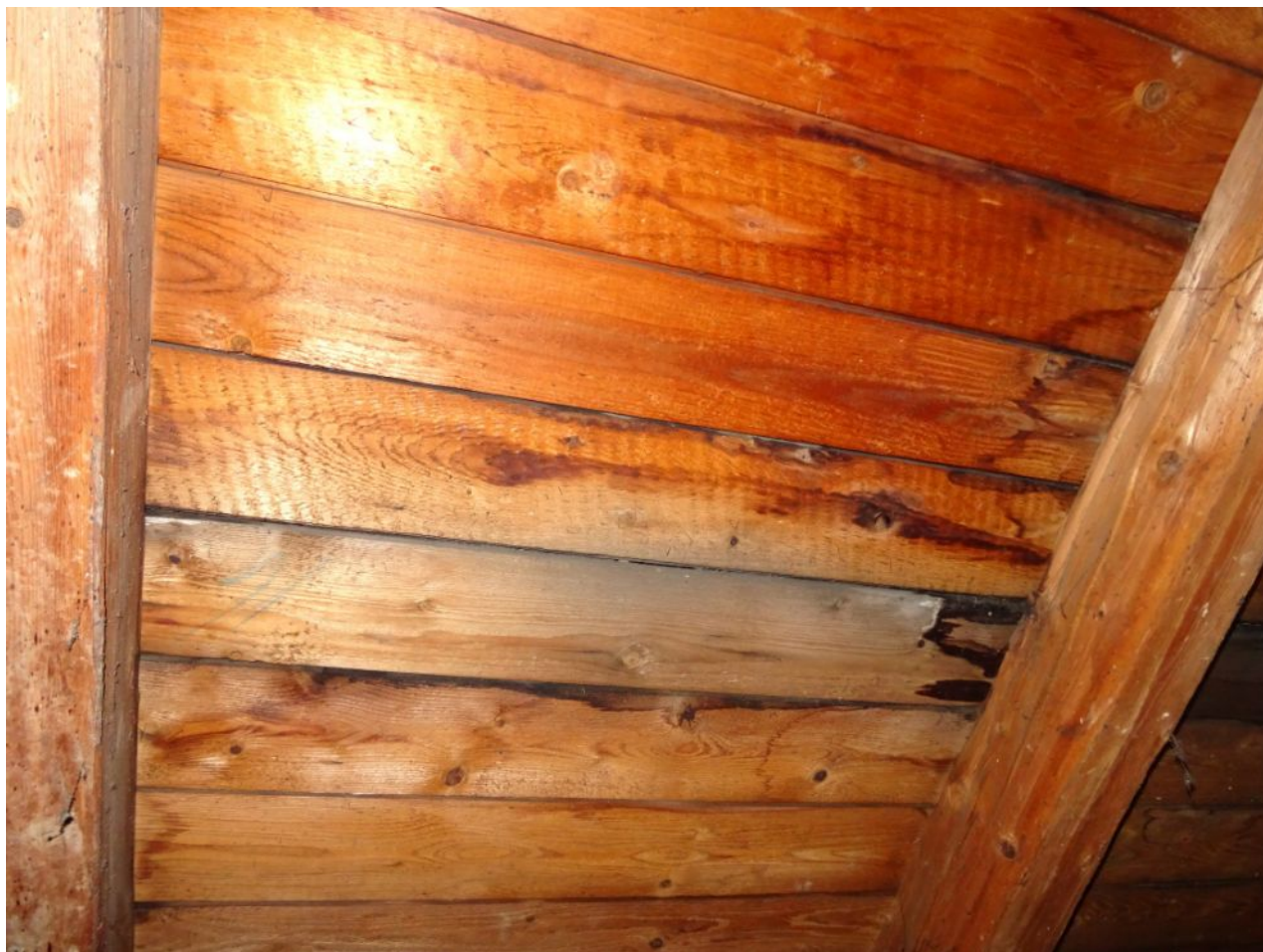
140 2NP Stopy zatékání podbití.jpg
