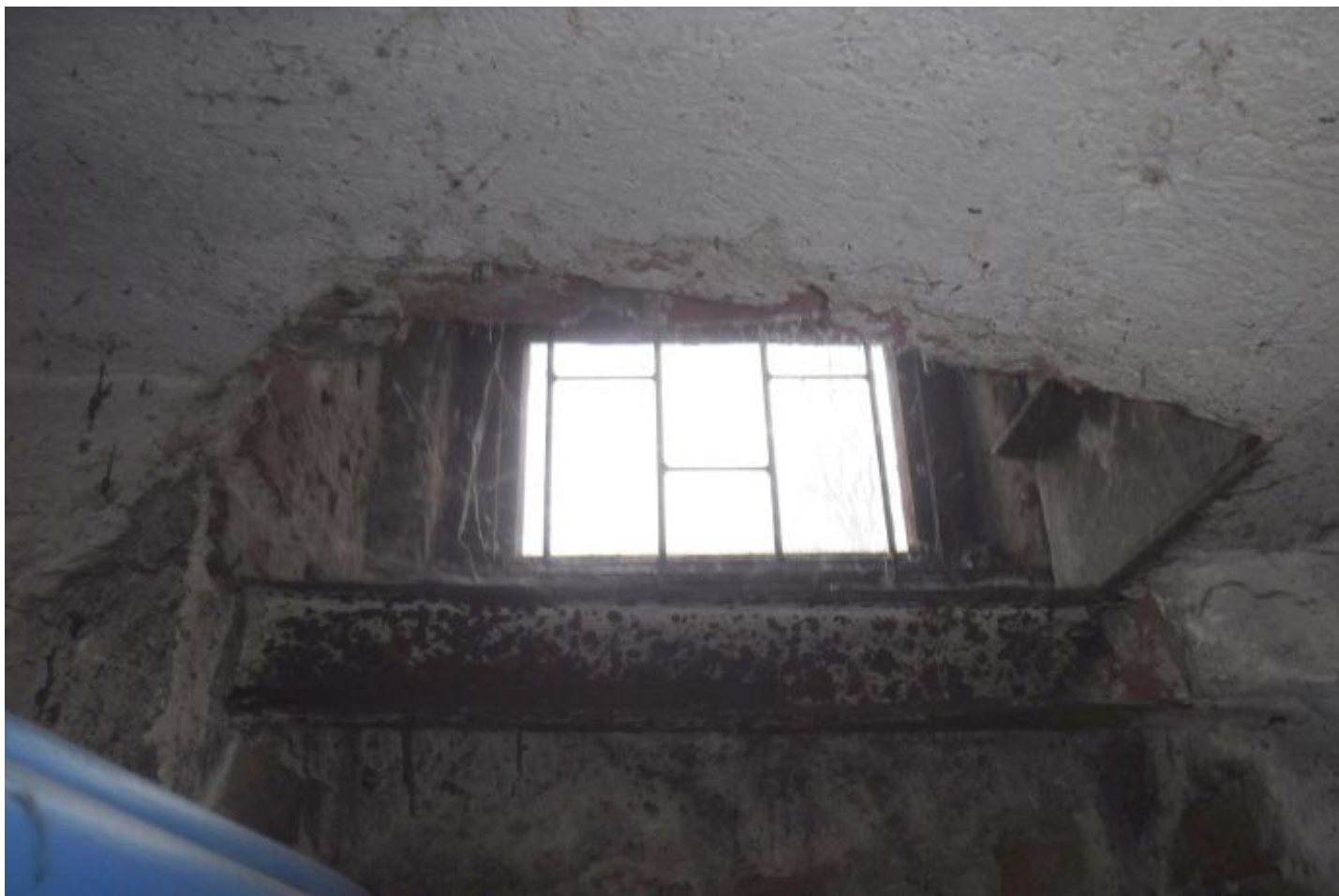
058 Povrchová koroze ocelového neošetřeného prvku.jpg
