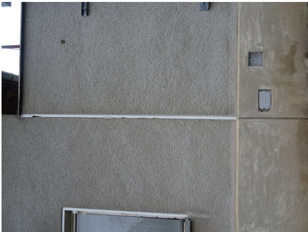
019 Pohled na dilataci mezi původním objektem a přístavbou.jpg
