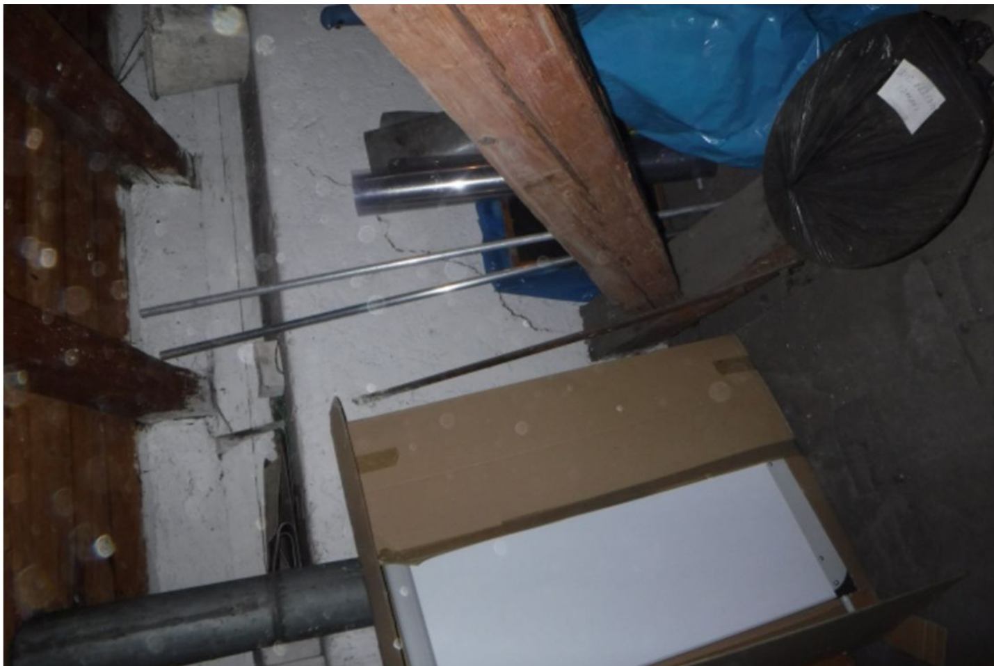
143 2NP Uložení vazného trámu do stěny a trhlina.jpg
