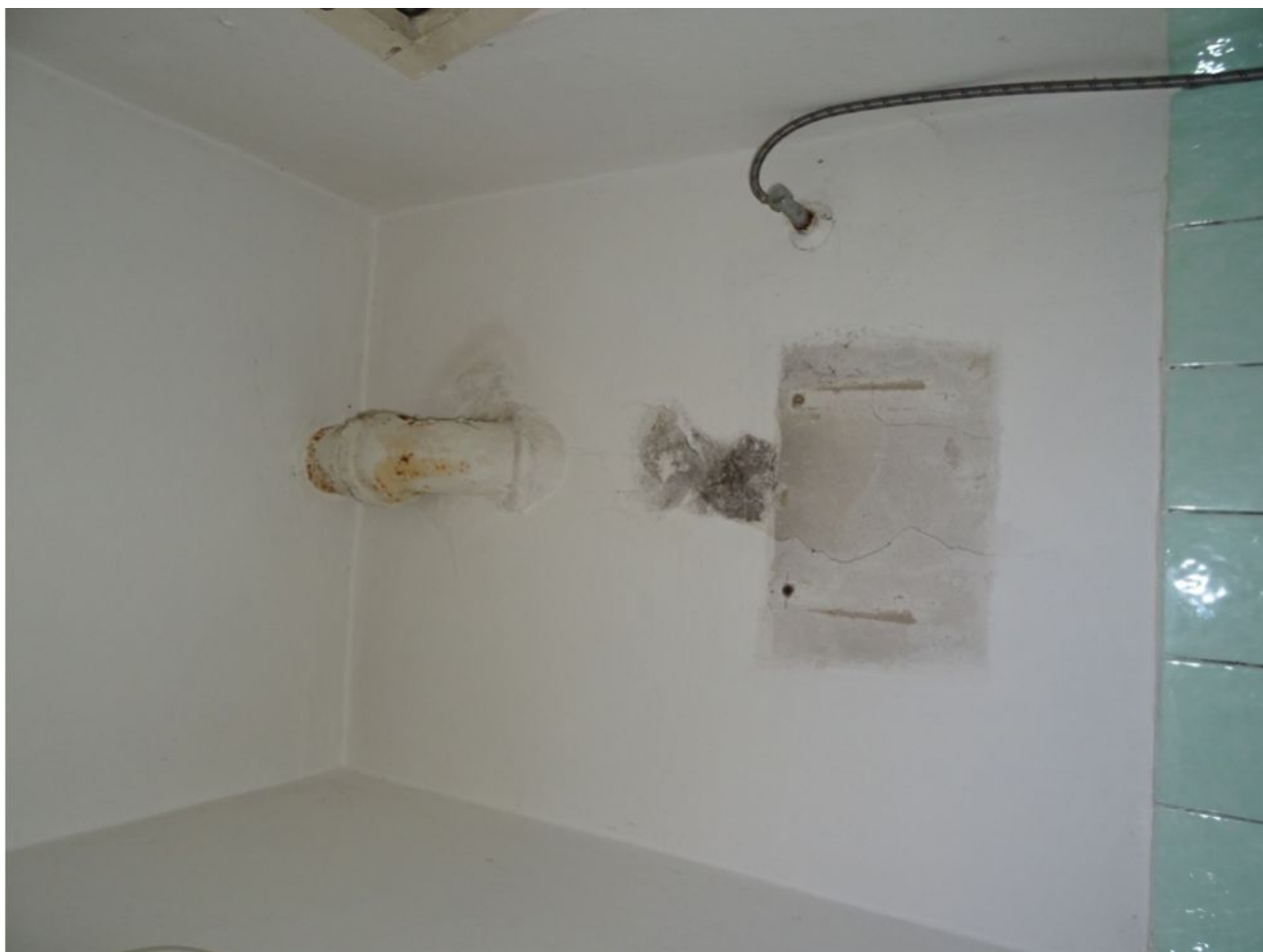
105 1NP Služební WC - zatékání.jpg
