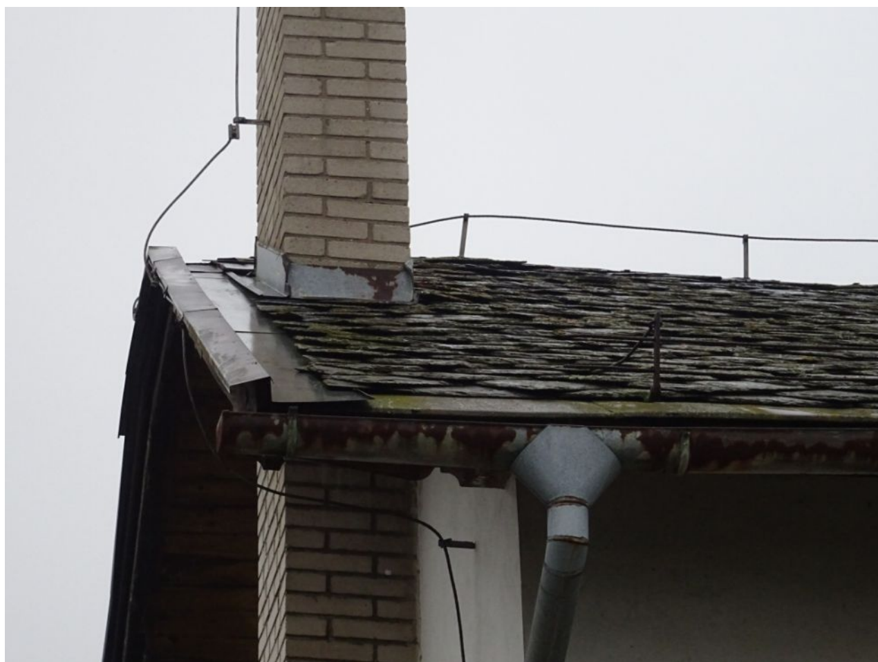
036 Pohled na prostup komínového tělesa plochou střechy.jpg
