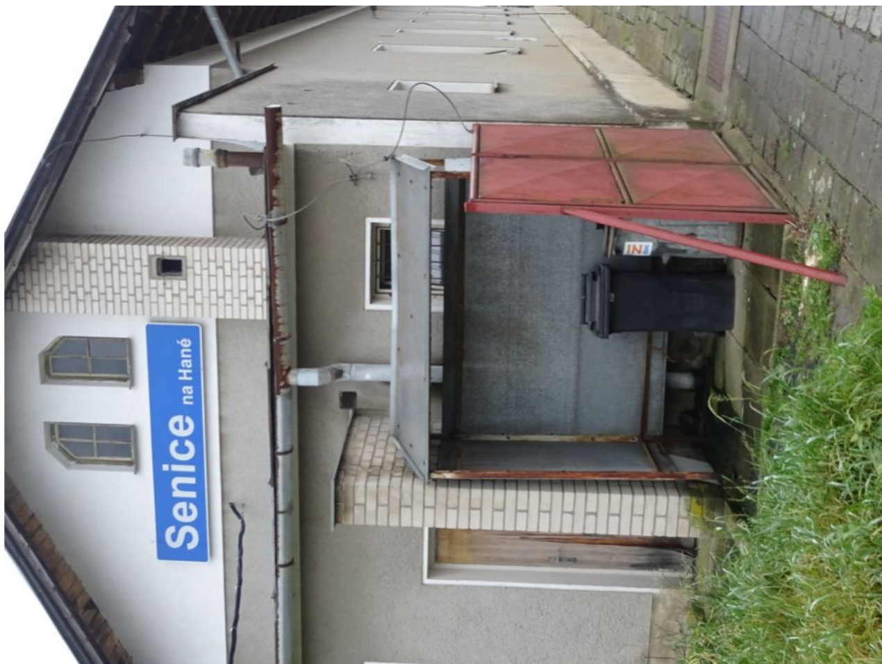
031 Přístřešek na popelnice a koroze okapových svodů.jpg
