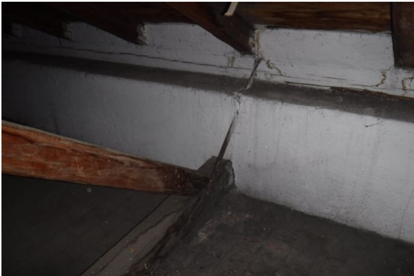
141 2NP Uložení vazného trámu do stěny a trhlina.jpg
