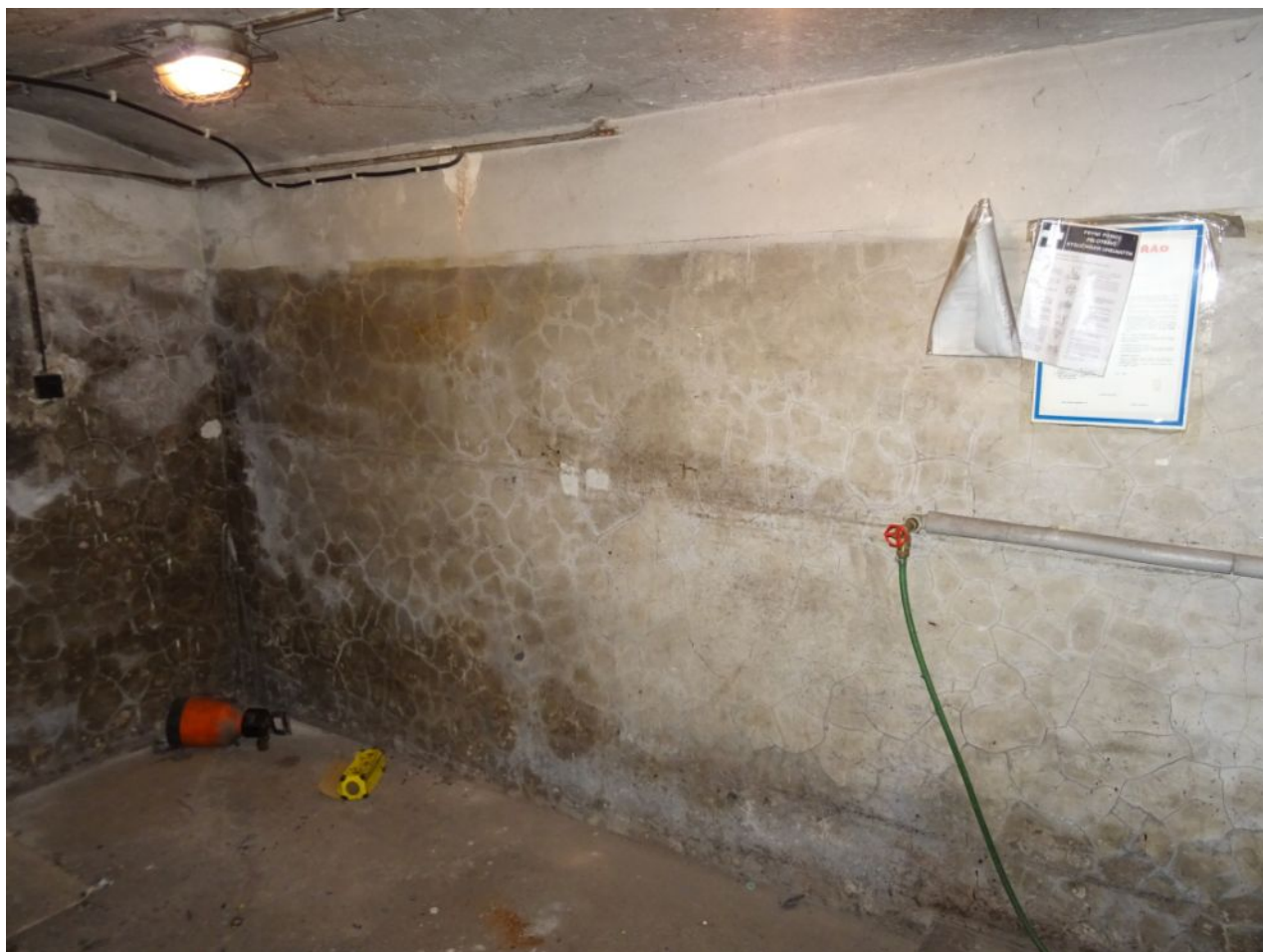
061 Poruchy kletované omítky v kotelně v suterénu.jpg
